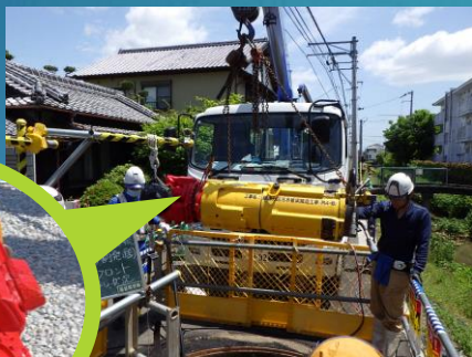
先導体吊降ろし状況
