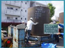
クラムシェルという機械で土砂を掘削、取り出しながら およそ5mのケーシングを地下に建込む工事を行いました。
