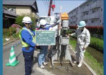
ボーリングマシンという機械で薬液を地下に流し込み、 地盤を安定させる工事を行いました。
