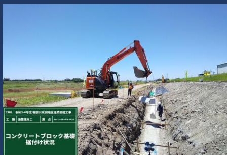
コンクリートブロック基礎 据付状況
