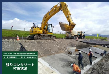
張コンクリート 打設状況
