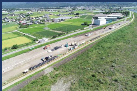
現在の進捗状況 (ドローンによる空撮)
