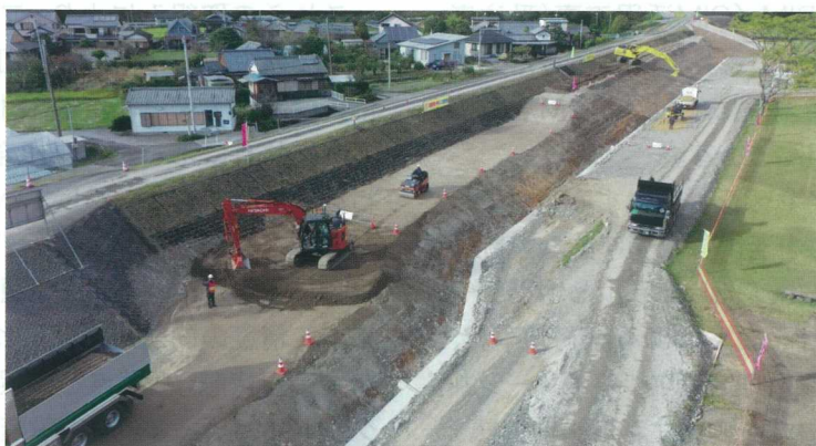
図-2 ICT活用による現場効率化
