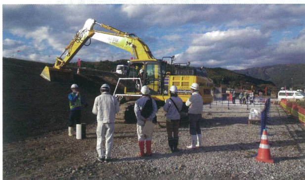
図-10 マシンコントロールバックホウによる施工体験
