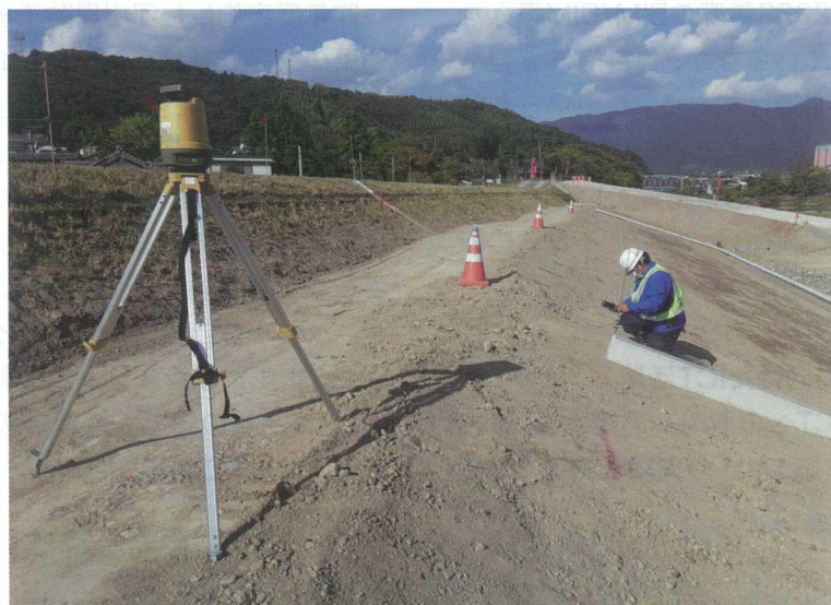
図-4 3次元データを活用したワンマン測量の実施
