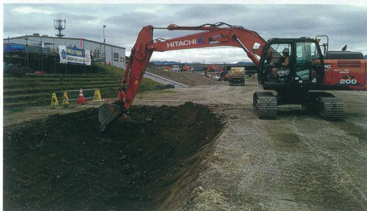
図-1 無丁張による床掘状況
