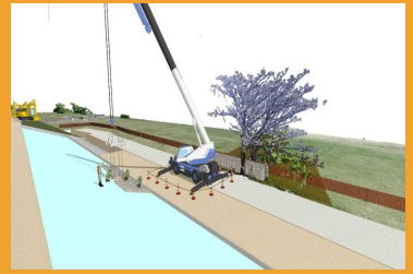
覆土ブロック据付状況
