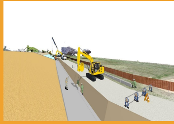
コンクリートブロック基礎据付状況
