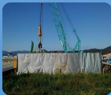
防音シート設置
