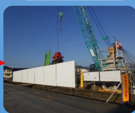
フラットパネル設置
