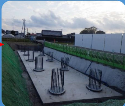
杭頭処理完了
