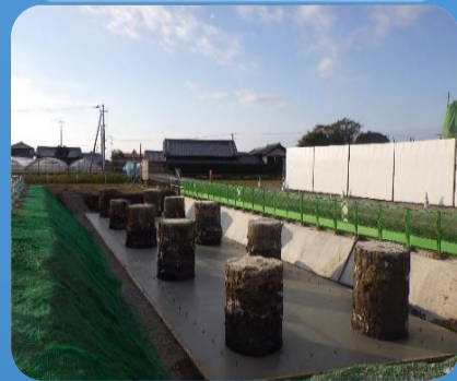
基礎杭施工完了
