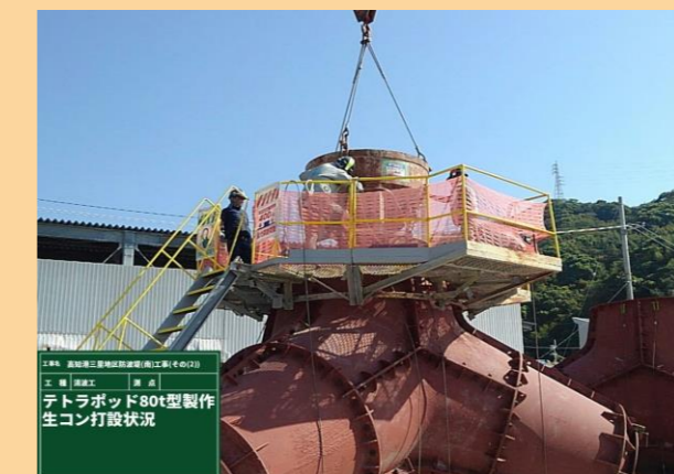
4. 上部コンクリート打設
