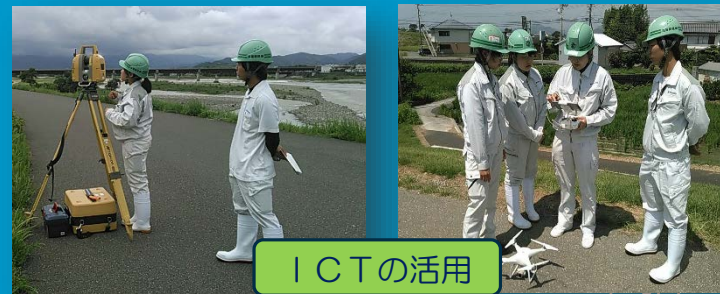
起工測量(TLS測量)・3次元地形データ作成
