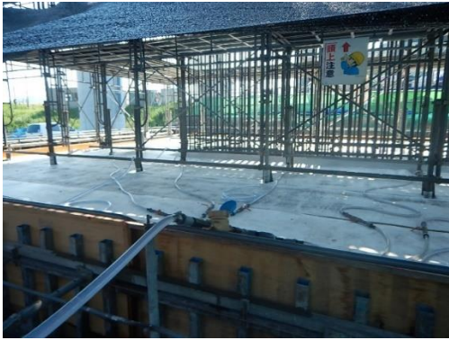
図-10 湛水養生状況
