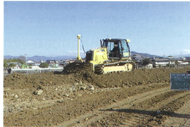
写真-9 MCブルドーザーによる盛土材敷均し状況
