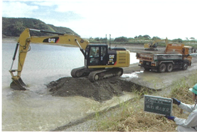
写真-8 MGバックホウによる水中部掘削状況
